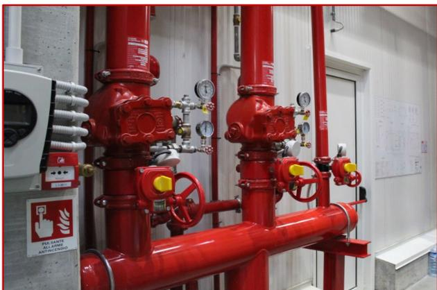
Cassioli поставила также инновационную противопожарную систему с цистерной и запасом воды, спринклерами, внутренней и наружной сетью гидрантов, насосной станцией и установками обнаружения дыма согласно действующим нормам.
